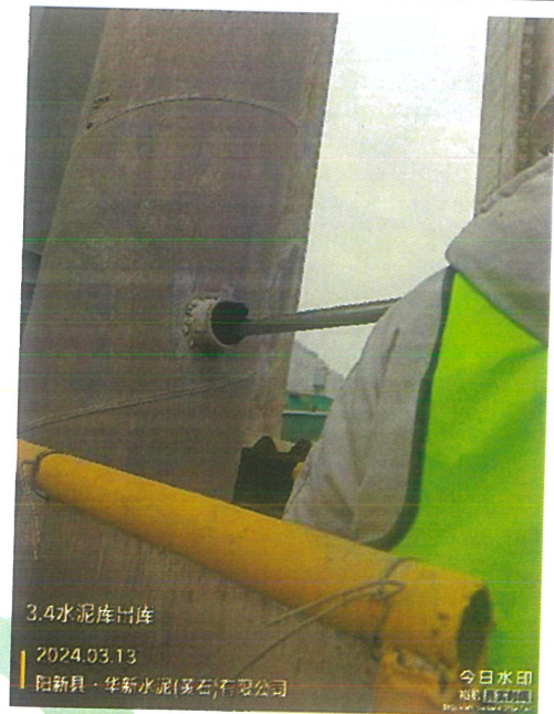
DA029 3、4 水泥库出库排气筒采样口◎13
